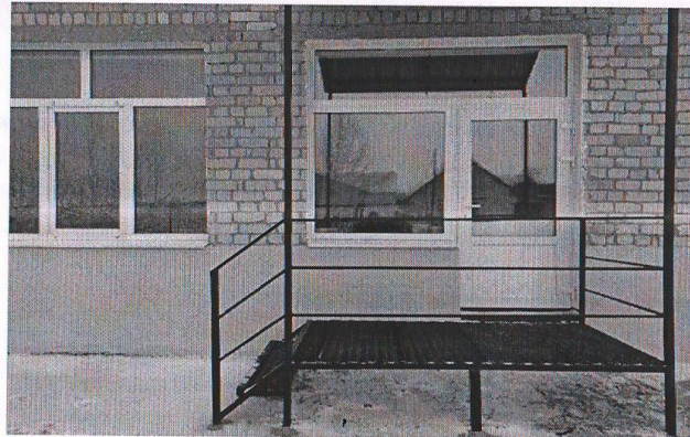
7. Эвакуационный выход №3 детский сад
