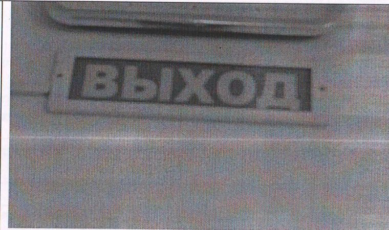
24 визуальное средство путей эвакуации
