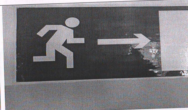
21 визуальное средство путей эвакуации
