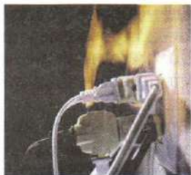
Рис. 89. Короткое замыкание в электропроводке
