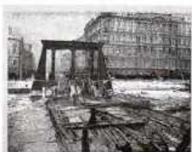
Разрушенный Египетский мост
