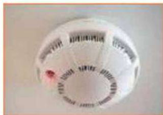
Рис. 4.7. Блок датчиков пожарной сигнализации
