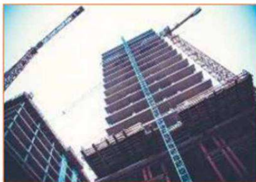
Рис. 7.1. Монолитное строительство с применением химического фрезерования
