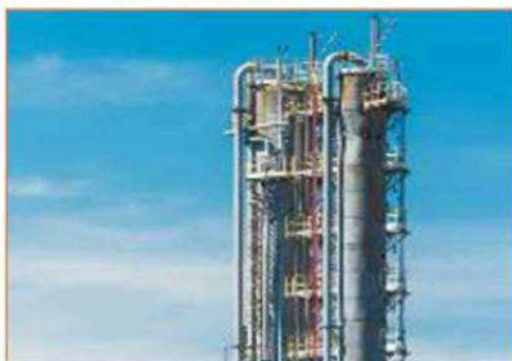
Рис. 5.14. Промышленная ректификационная колонна
